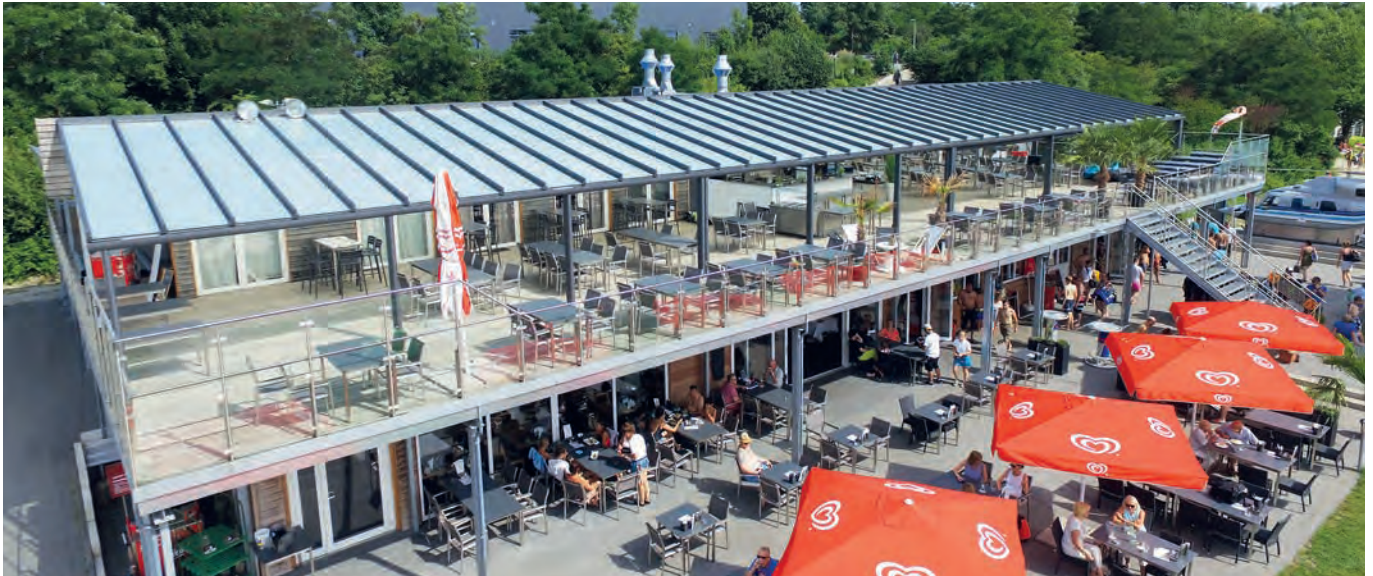
Rooftop Bar, Beckum: XXL Glasdach für die Gastronomie mit 7,4 Meter Sparrenlänge, 41 Meter Länge, insgesamt 380 qm
